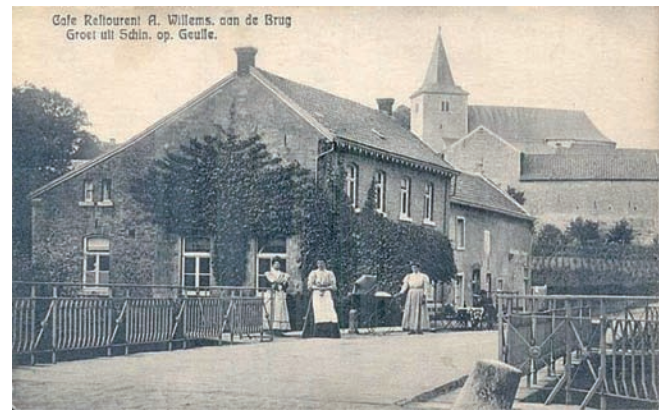
Het voormalige tolhuis nabij de Geulbrug aan de Breeuweg, ongeveer een eeuw geleden. Het was toen een café-restaurant dat geëxploiteerd werd door A. Willems
