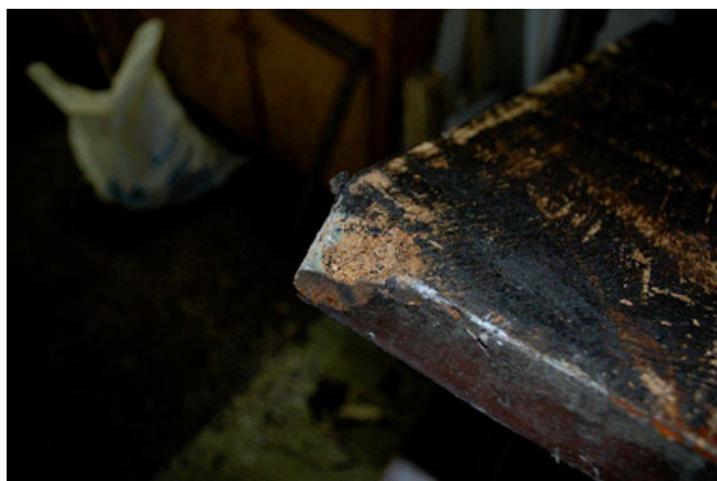
Het oude dak is rot en wordt vernieuwd. Een nieuwe dakbedekking van zink moet voorkomen dat er wederom water in kan komen
