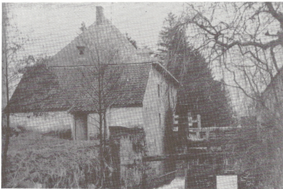
Foto van de Sjoens-meule genomen voor 1924. Het grote houten waterrad werd in 1924 vervangen door een turbine.
